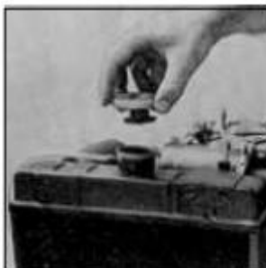
Deckel öffnen und Kühlflüssigkeit einfüllen.
